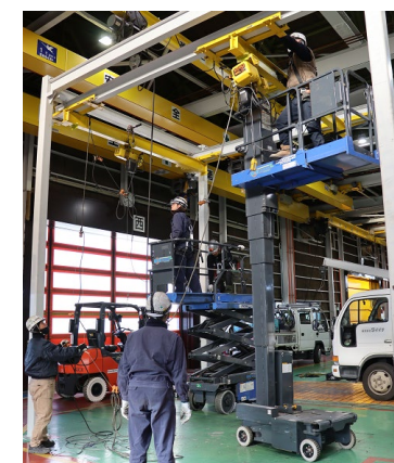
工場設備の組立
