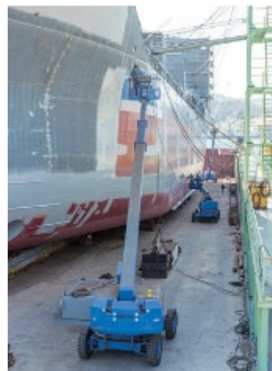
新造船の外板塗装
