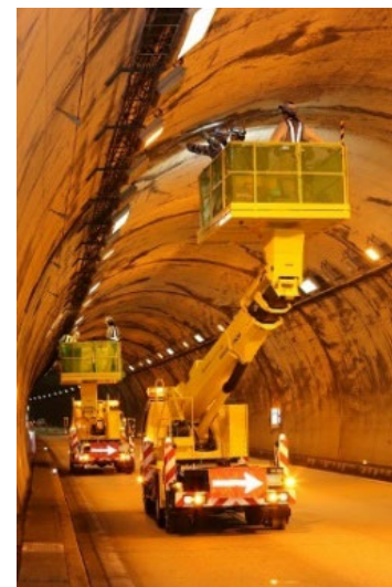
トンネル内壁の点検
