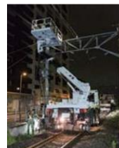
軌道設備の点検
