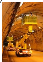
トンネル内壁の点検
