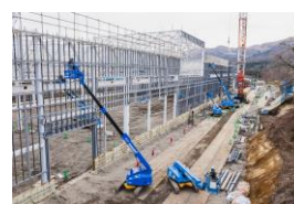
無足場工法による大型施設の建設
