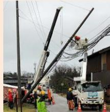
倒壊電柱の改修作業への建柱車、高所作業車の供与
