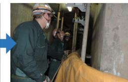
電柱側から新しいケーブルを挿入、U302で新しいケーブルを送り出しながら、洞道側から作業員がけん引
