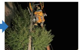
電柱にケーブルを立ち上げて高所作業車で接続、洞道側の接続も行う
