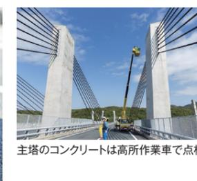
主塔のコンクリートは高所作業車で点検
