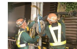
電柱に立ち上がっている古いケーブルを切断、立上げ管を抜いた後、電柱に金車（滑車）を取り付けてケーブルを通す
