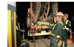
除去ケーブル後端に取付けたワイヤーと、新しく入線するケーブルをつなげる
