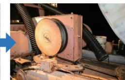
ケーブルのワイヤーと縁切りウインチのワイヤーを接続、縁切りウインチで古いケーブルをけん引し管路とケーブルの縁切りを行う
