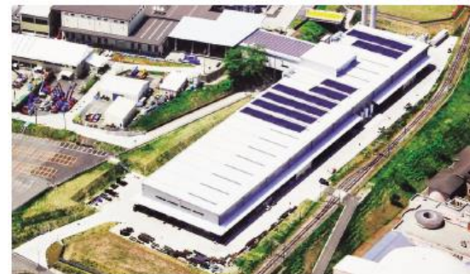
新治事業所に太陽光システムを増設し、2022年4月より稼働中
