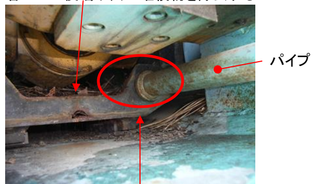
伸ワイヤ端部の錆点検(パイプ内を含む)
